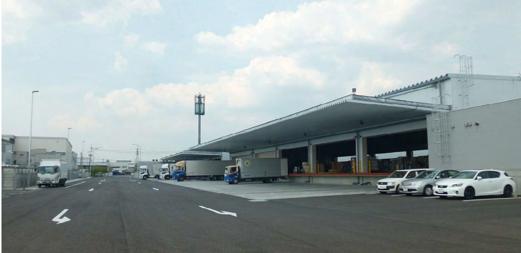
4/23 荷扱棟2が完成、6/4 外構(舗装)工事が完了しました。
