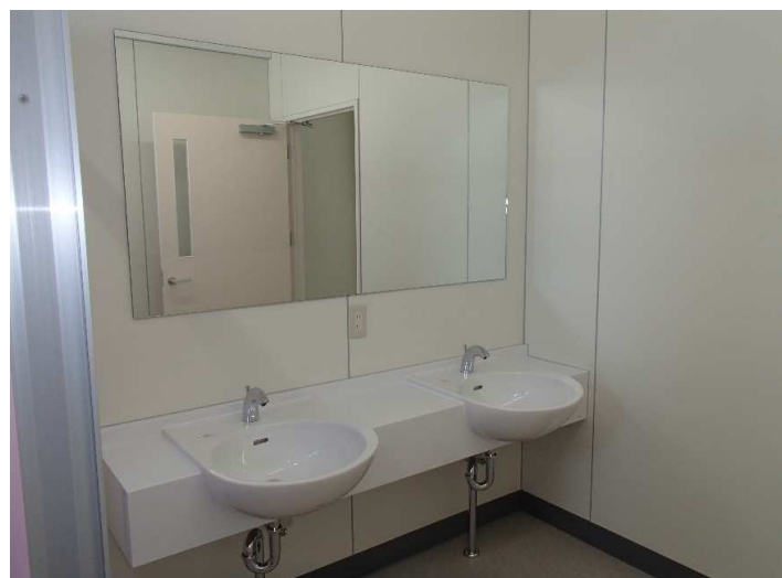
女子トイレ洗面台
